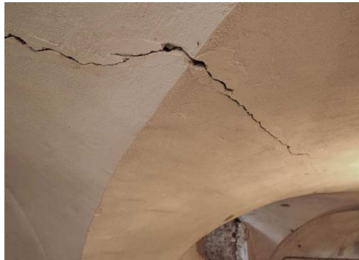
Herstel van scheurvorming souterrain
