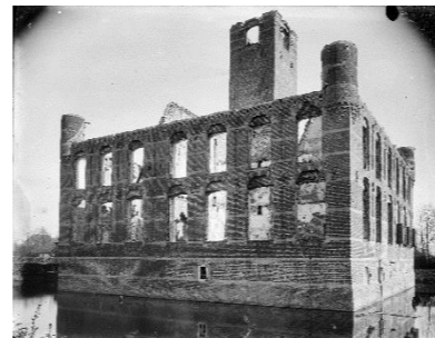
Na een schoorsteenbrand brandde het kasteel geheel uit. 1906
