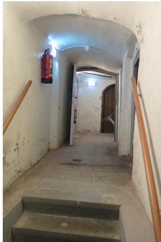
Route naar toiletten souterrain
