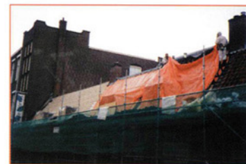
Het verwijderen van het asbest
