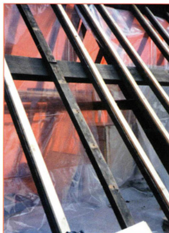
Het weer opvullen van de ragels zodat het dak beneden eindigt bij de goot
