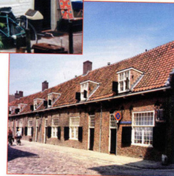
Voorgevel na restauratie (Gem. Fotodienst Utrecht 2000).
