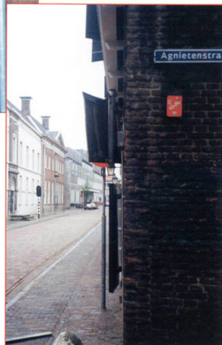
Afwijking in het metselverband aan de zijgevel in de Agnietenstraat
