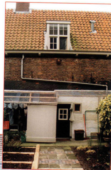
Oude situatie achtergevel
