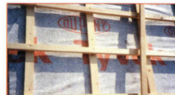
Het aanbrengen van isolatiemateriaal en het vastnagelen van de panlatten
