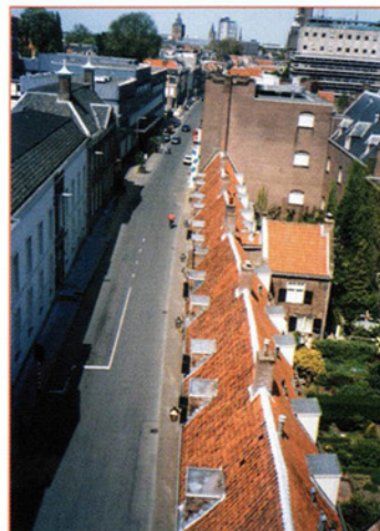
Bovenaanzicht zadeldak in de Lange Nieuwstraat.
