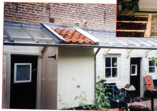
Achtergevel na restauratie
