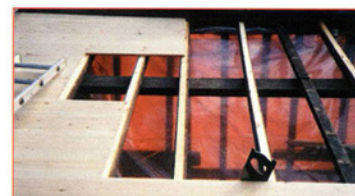
Het bevestigen van het dakbeschoot
